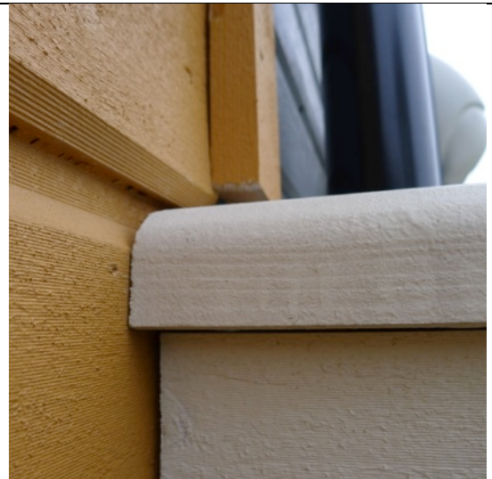
Bild 18. Omålat ändträ på lockläkt.
