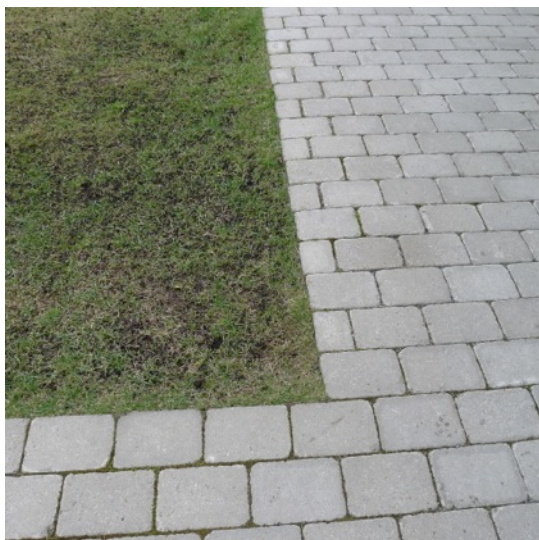
Bild 25. Kantsten saknas till plattläggning. Kantsten ska finnas där plattorna utsätts för hög belastning t ex infarter.
