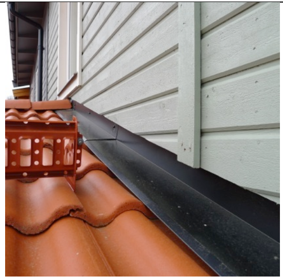
Bild 20. Fönster ansluter för tätt mot underliggande tak, uppdrag skall vara min 200 mm.
