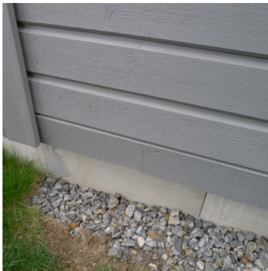
Bild 13. Skarvslutbräda får inte vara kortare än 2,0 m, förekommer på flera ställen.
