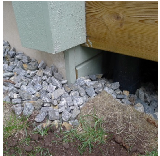
Bild 14. Panel brädor skall inte ha kontakt med mark, förekommer på flera ställen.
