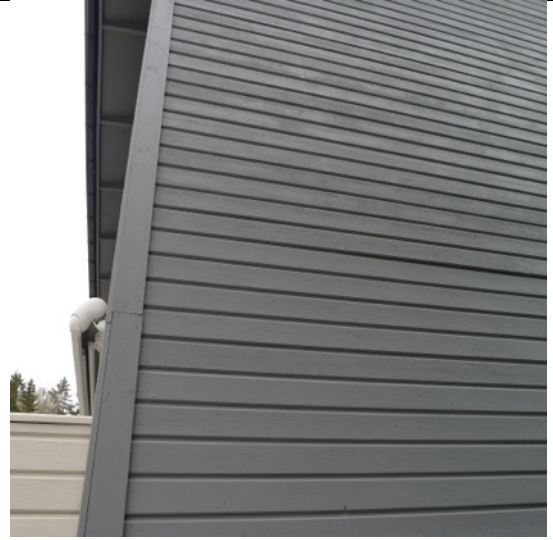
Bild 12. Skarvar i intilliggande bräder skall förskjutas minst 600 mm. Panel som skarvas ska snedskäras med fall utåt, se knutbrädor.
