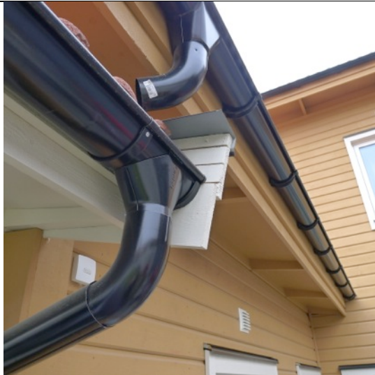
Bild 9. Överspolningsskydd bör monteras på den lägre rännan, vid utkastaren från den högre. Vid häftigare regn så flödar rännan över.
