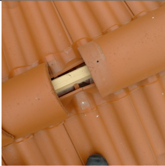
Bild 7. Ej spikad nockpanna, det förekom flera stycken. Nockpannor ej tätade enligt Benders anvisningar.
