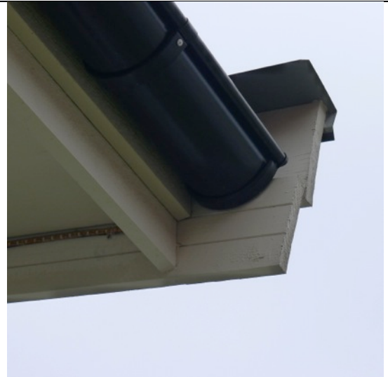
Bild 10. Vindskivor håller olika kvalitet, främst ett estetiskt fel.
